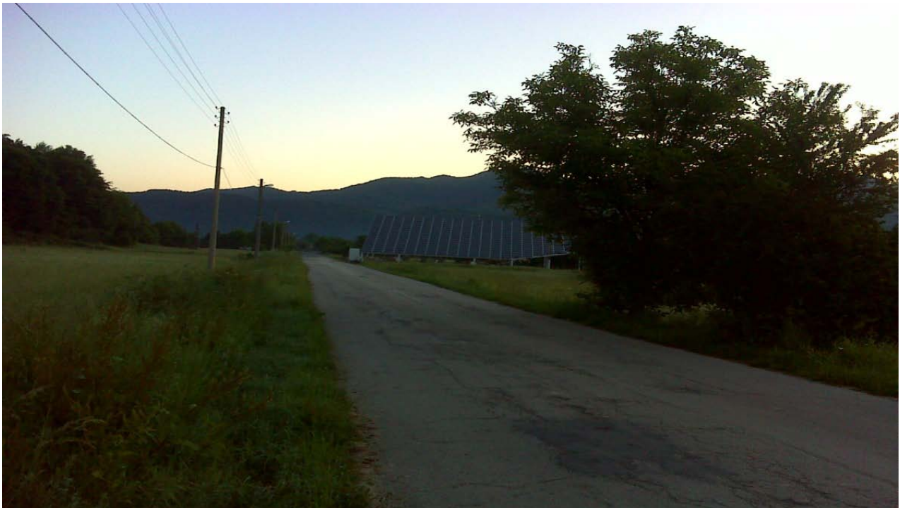
Снимка 59. Изграждане на фотоволтаична инсталация в ЗЗ „Априлци”
