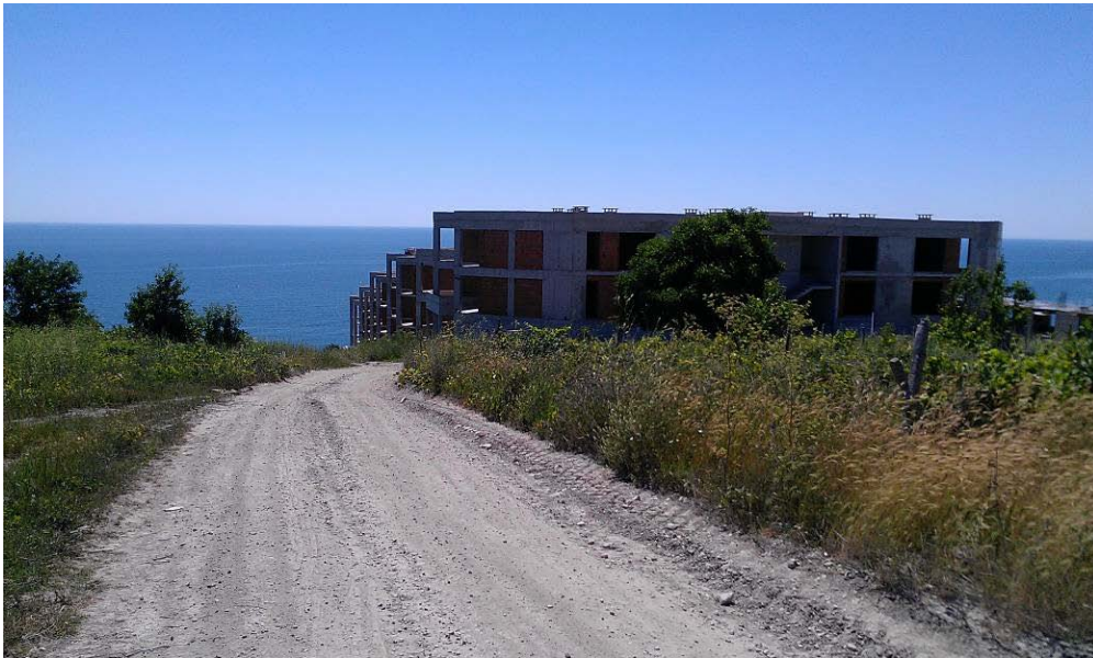
Снимка 19 Строителство на вилно селище в ЗЗ „Камчийска планина“
