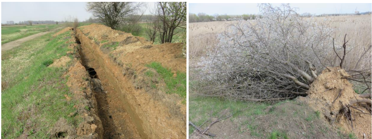
Сн. 2 Вандалски актове в Рибарници Орсоя – изваждане на тръбите от помпената станция и изкореняване на дървесна растителност по дигите.
